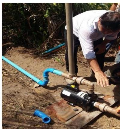
Imagem 28: bomba centrífuga instalada com retorno para a caixa.
