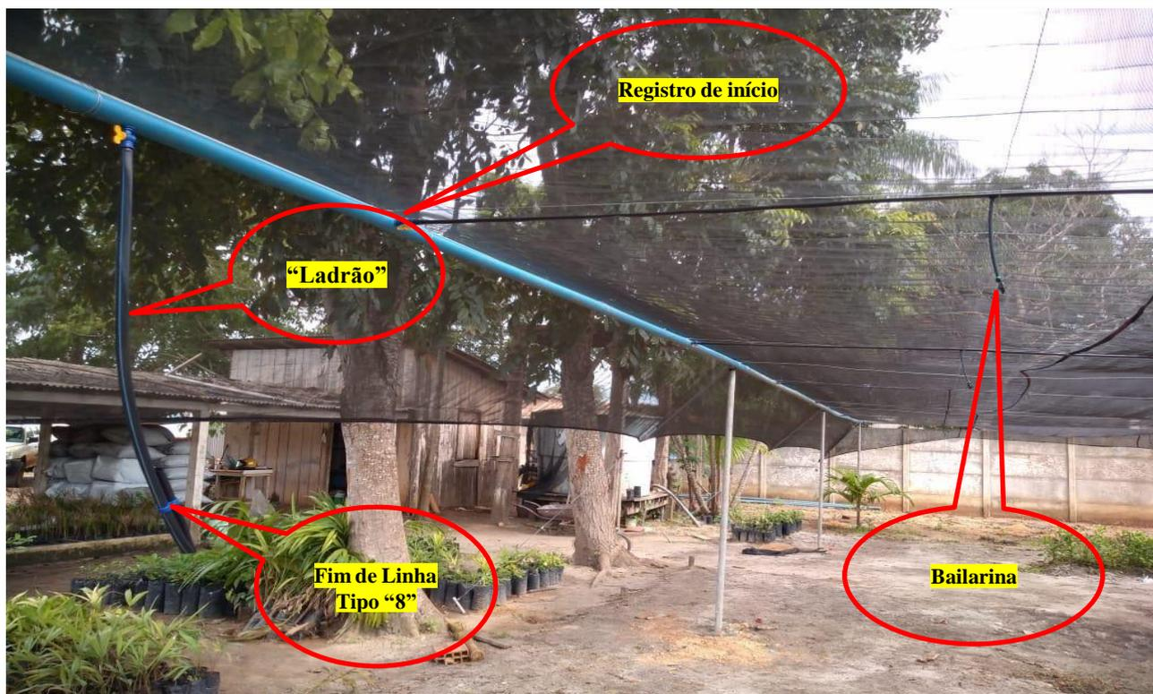
Imagem 26: Sistema de Irrigação Concluído: tubulação principal (tubo azul 50 mm), linhas laterais (tubo pelbd 16 mm), microaspersores e ladrão.
