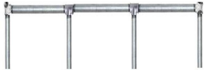
Figura 04: Lateral 01 montada e pronta para ser erguida e assentada nos buracos feitos no solo para as colunas
