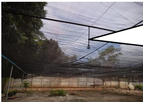
Imagem 25: Microaspersor Instalado.
