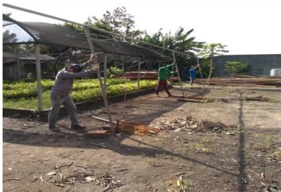
Imagem 08: Levantamento de uma Lateral Pré-montada
