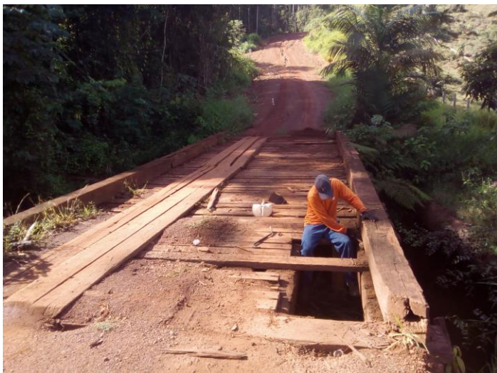
Foto 05 – Antes e depois de ponte consertada
