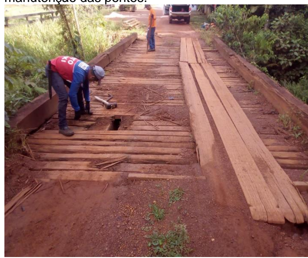
Foto 04 – Retirada de peças que apresentavam defeitos.
