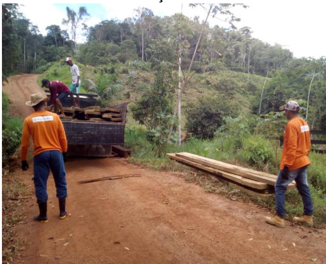
Foto 01 – Distribuição das peças para a manutenção das pontes.
