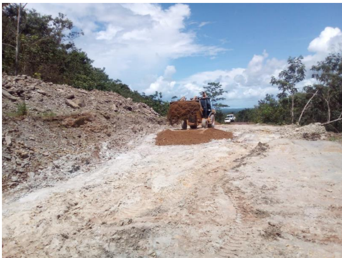
Foto 03 – Retroescavadeira jogando material na estrada do PDS Serra Azul.
