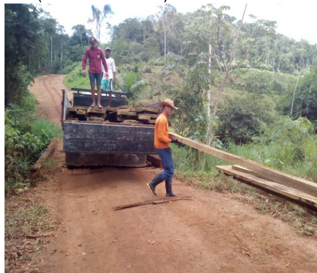
Foto 02 – Distribuição das peças para a manutenção das pontes.
