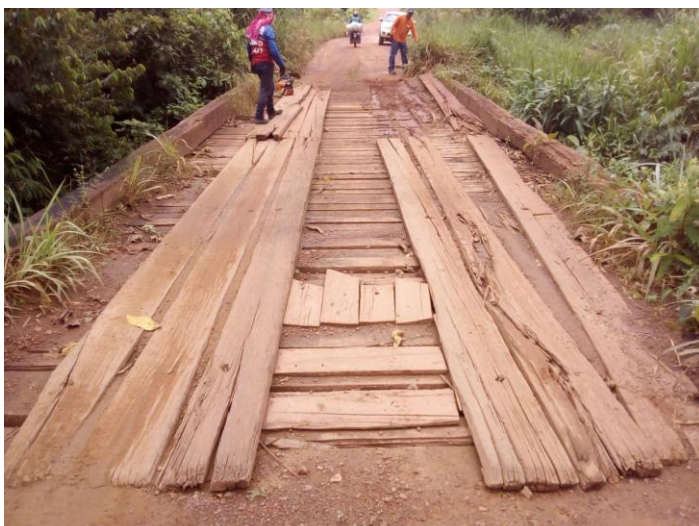
Foto 08 – Antes e depois de ponte consertada
