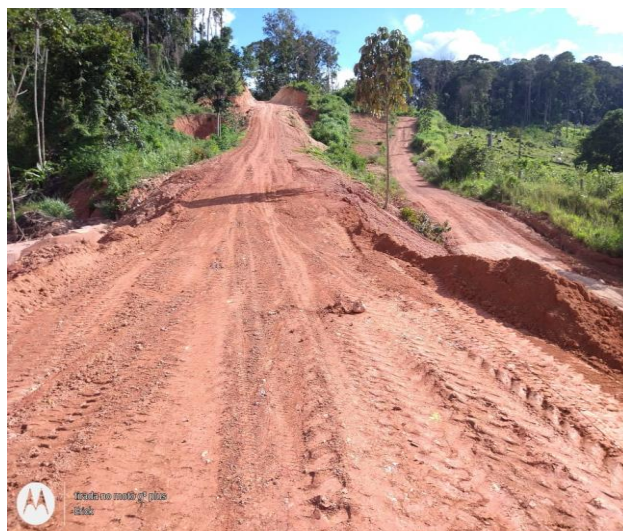
Foto 10 – Estrada após as intervenções realizadas.
