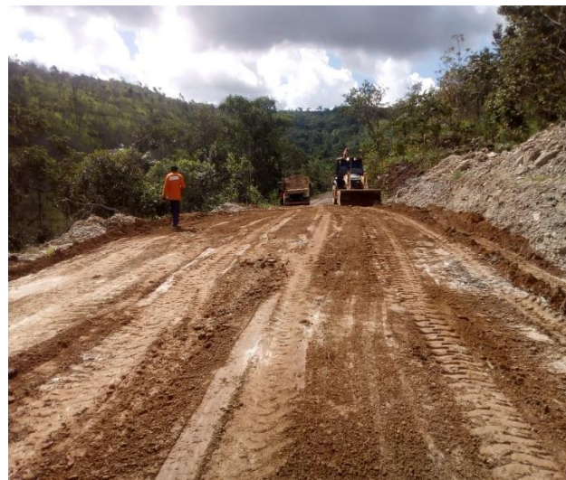
Foto 04 – Retroescavadeira espalhando o material na estrada do PDS Serra Azul.
