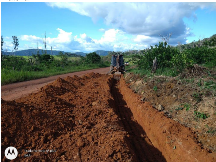
Foto 07 – Retroescavadeira abrindo valas laterais para escoamento da água.
