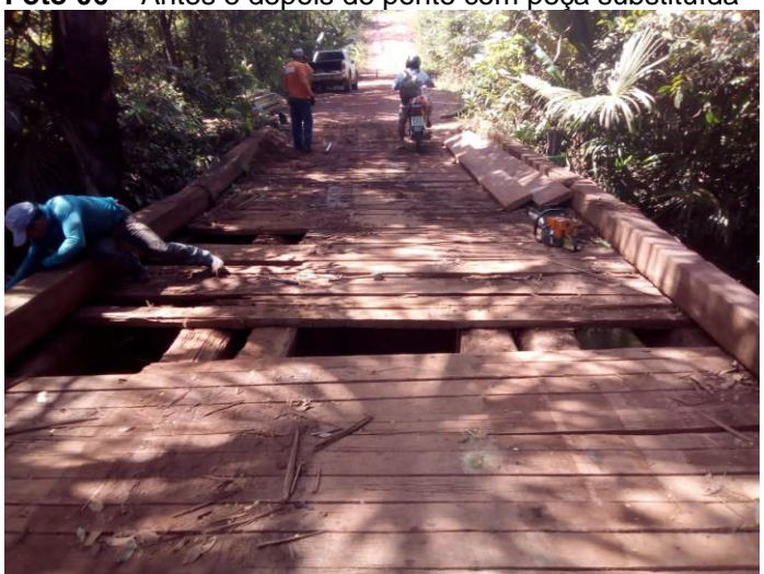
Foto 07 – Antes e depois de ponte consertada
