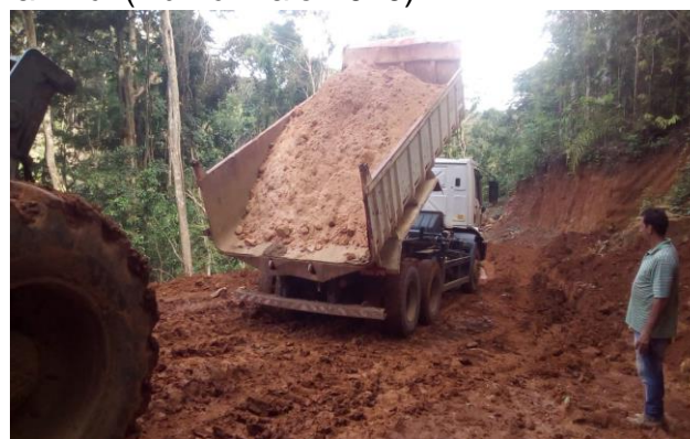
Foto 02 – Caçamba descarregando o material em local da estrada.
