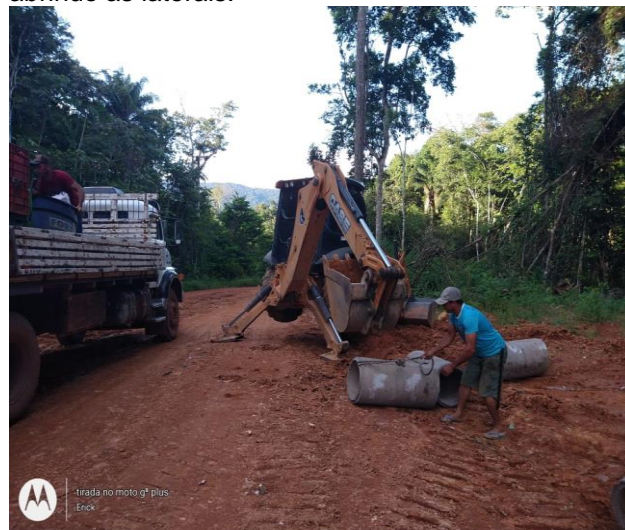
Foto 08 – Retroescavadeira pegando as tubulações para colocar na estrada.
