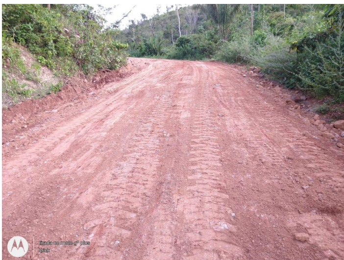
Foto 09 – Estrada após as intervenções realizadas.
