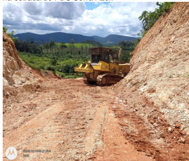
Foto 06 – Trator fazendo a terraplanagem e abrindo as laterais.
