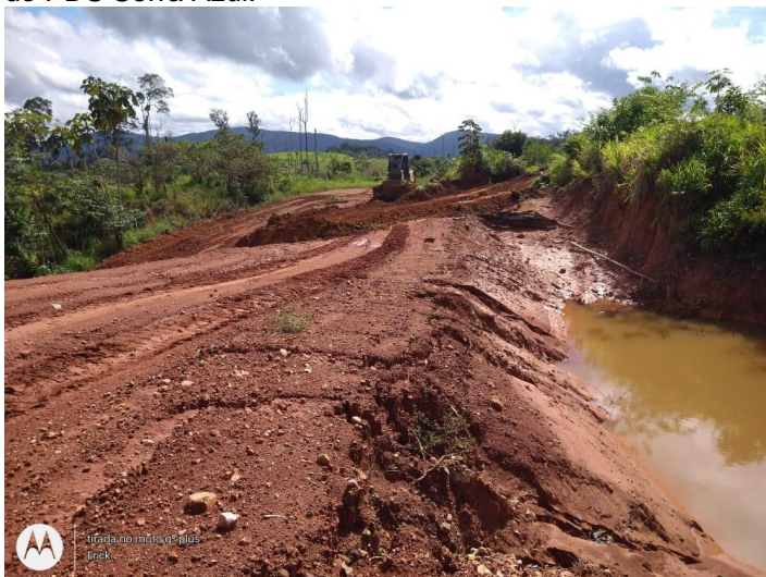
Foto 05 – Trator fazendo a terraplanagem e espalhando o material.
