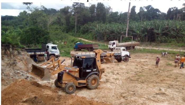
Foto 01 – Retroscavadeira pegando material para colocar na caçamba.
