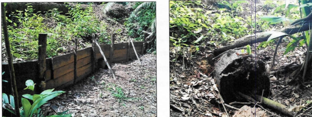
Figura 10 – Bueiro, UMF II, Flota do Paru.
