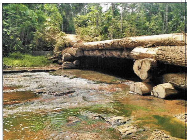
Figura 11 – Bueiro, UMF II, Flota do Paru.
