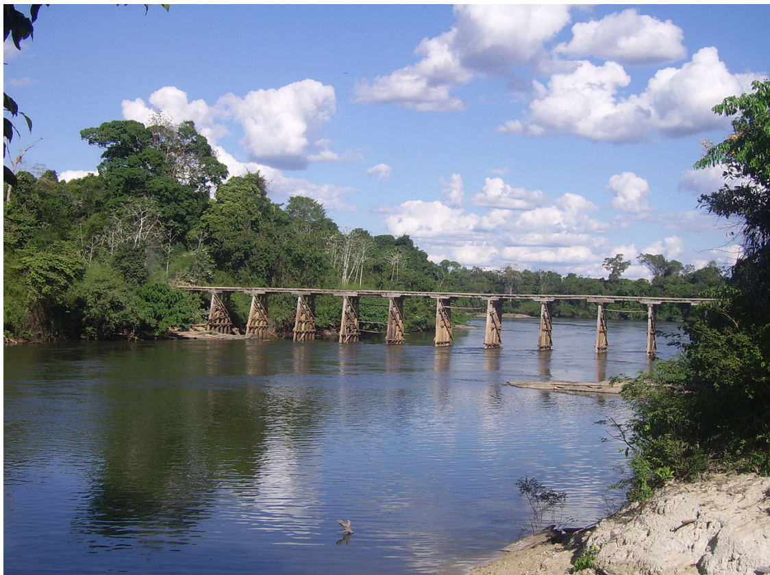
Figura 131- Ponte sobre o rio Jamanxim, na região de Novo Progresso.
