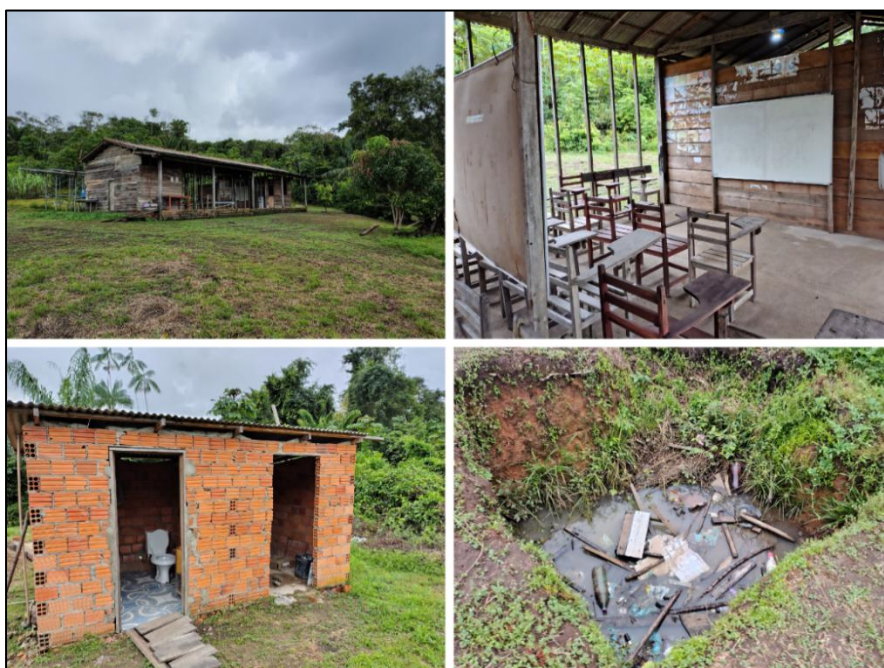
Foto 15 Unidade de ensino na comunidade Nazaré, com vista das salas de aula e banheiros
