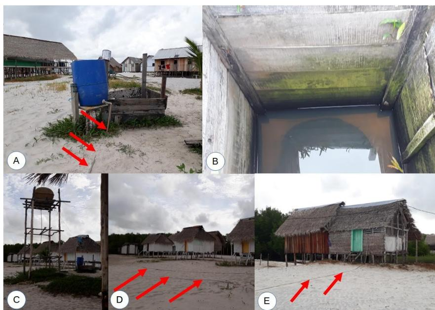
Figura 19: Estrutura de abastecimento de água no centro da Praia de Croa Nova (A); Vista do poço amazonas (B); Vista da estrutura elevada (C); e Tubulações de abastecimento para alguns barracos, detalhe em vermelho (D, E) (IDEFLOR-BIO, 2019)
