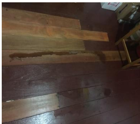
Figura 14- Registro das áreas com problemas de umidade e goteiras no escritório cedido para o IDEFLOR-Bio.
