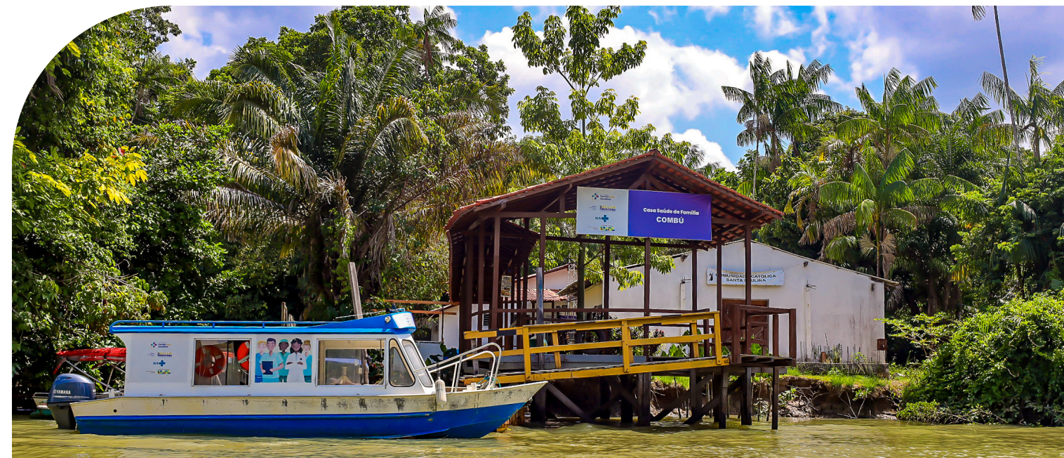
Figura 16. Centro de saúde da APA Ilha do Combu, localizado na comunidade do Igarapé Combu. Fonte: Bruno Cruz (SECOM)
